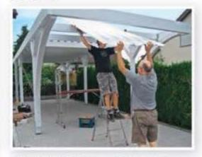
DACHMONTAGE: Bevor die Dacheindeckung mit Trapezbahnen fixiert wird, sollten alle Platten ausgelegt werden. So ist sichergestellt, dass neben den seitlichen Überständen auch die Überlappungen gleichmäßig und korrekt ausgerichtet sind.
