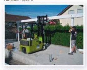
SATTELBALKEN: Durch das Aufstellen der Pfosten nimmt der Carport langsam Form an. Nun geht es an das Errichten des Daches, welches mit dem Auflegen der Sattelbalken beginnt. Halt bekommt die Konstruktion durch Schlossschrauben.
