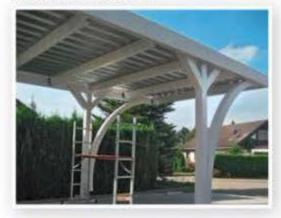
DACHFIXIERUNG: Zum Schluss werden die Dachbahnen mit Dübeln an der Holzkonstruktion befestigt. Unterlegscheiben aus Gummi sorgen dafür, dass die Platten bei Temperaturschwankungen genügend Bewegungsspielraum haben.
