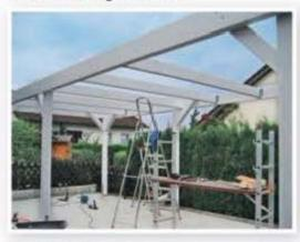
SPARREN: Für weitere Stabilität sorgen die Sparren, die im Anschluss an den Sattelbalken befestigt werden und das Dach fast vervollständigen. Das rechte Maß der Sparren ist von besonderer Bedeutung, denn die kleinste Abweichung gefährdet das Projekt.
