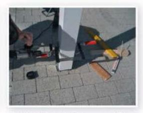
GRUNDPFOSTEN: Ist der Beton ausgehärtet, setzt man die Pfosten in die H-Anker ein. Dabei sind die Pfosten auszurichten und mit gleichen Abständen innerhalb der Anker zu platzieren. Dann werden sie vorgebohrt und verschraubt.
